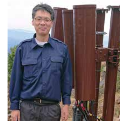
富山県立山地区の室堂山(2,668m)に携帯基地局設置。3年越しの事業でしたが感無量でした。
