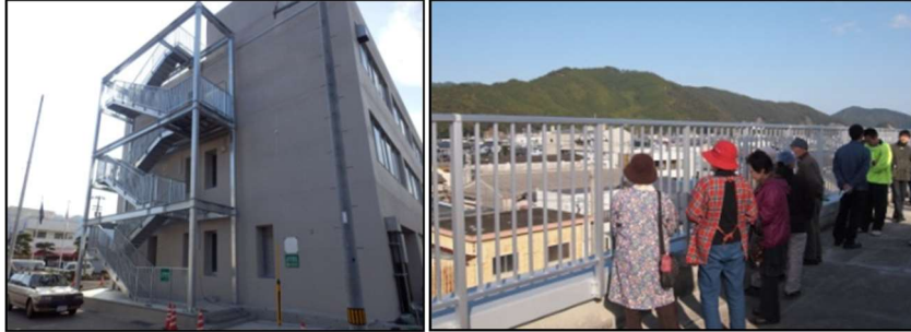
図 3-2-1-9 (左) 屋外避難階段の設置例 (日和佐合同庁舎)、(右) 住民見学会の開催 (同左)
