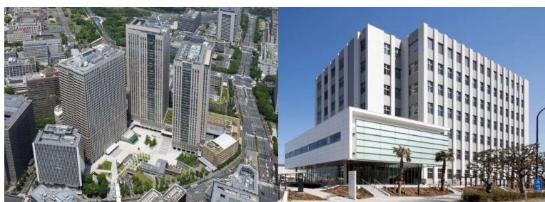
図 3-2-1-1 （左）Ⅰ類施設の例（中央合同庁舎 7 号館） （右）Ⅱ類施設の例（横須賀地方合同庁舎）
