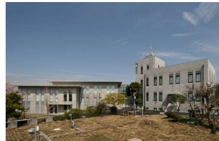
図 3-2-3-11 横浜地方気象台庁舎
