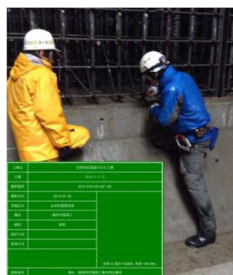
図 4-2-2-5 ICT 建築土工のイメージ
