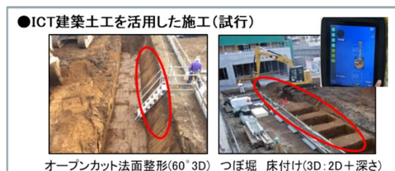
図 4-2-2-4 ICT 建築土工のイメージ
