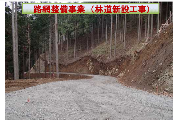
平成26年度 南信森林管理署 観音沢林業専用道新設工
