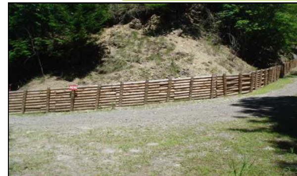
平成29年度 南信森林管理署 星ヶ塔林道改良工
