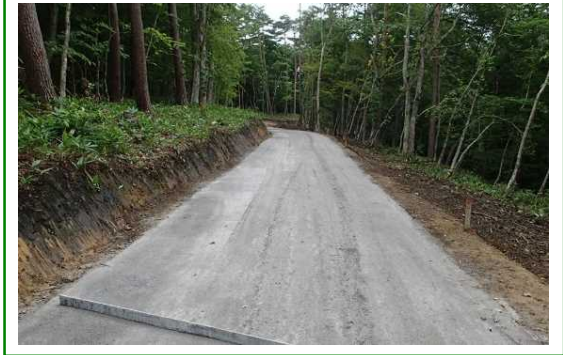
林道（林業専用道）新設
