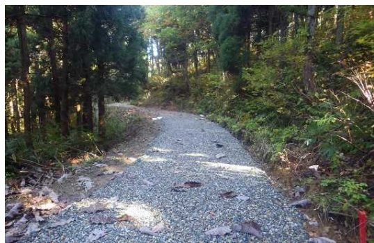
林道（林業専用道）新設
