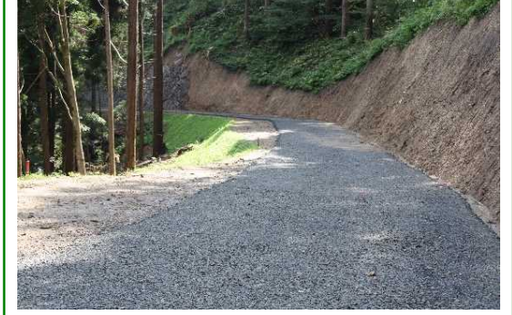
林道（林業専用道）新設
