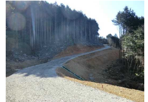
愛知森林管理事務所 葦毛林道新設工事
