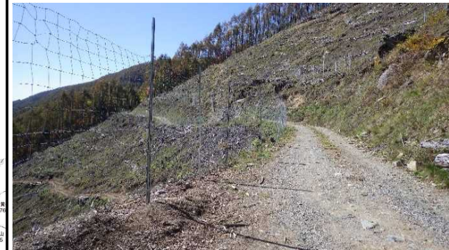
南信森林管理署 シカ柵設置
